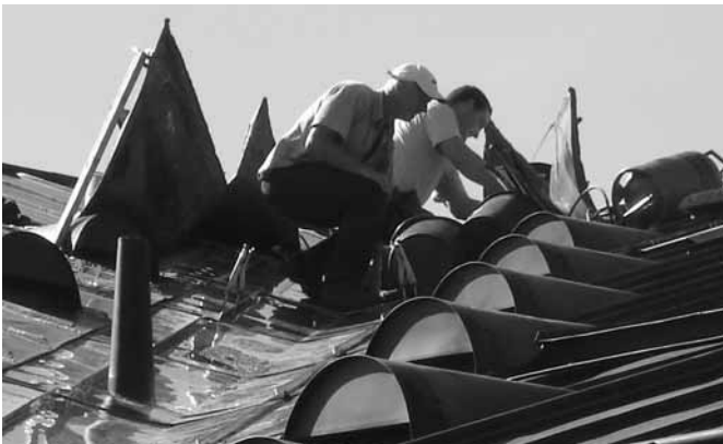
Reparatur des Kirchendaches
