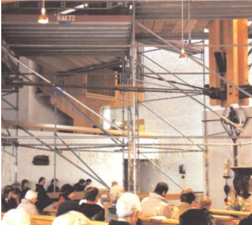
Drei Wochen lang war unsere Kirche eine große Baustelle
